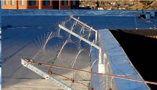
지붕 난간 어레이(Parapet Array) 산업용 빌딩 및 상업용빌딩에 적용되며 옥상의 난간을 이용하여 설치.
