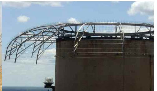
연돌 어레이(Stack Array) 연돌이나 배기 가스 분출구등에 적합하며 내열,내부식 구조로 설계.
