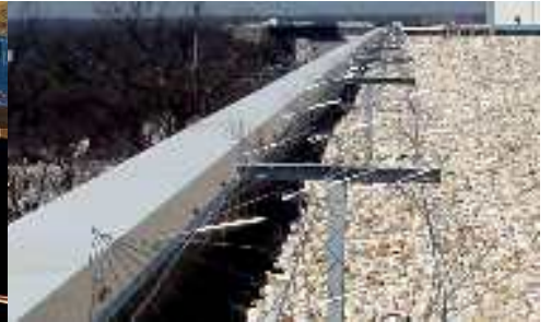
옥상 어레이(Flat Roof Array) 평면옥상에 설치되며 난간어레이와 병용하면 효과 적임.
