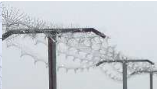
파라곤 어레이(Paragon Array) 옥외 장구간의 전력 및 통신 선로 보호.
