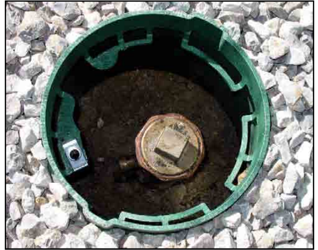
설치 후 접지 점검구
